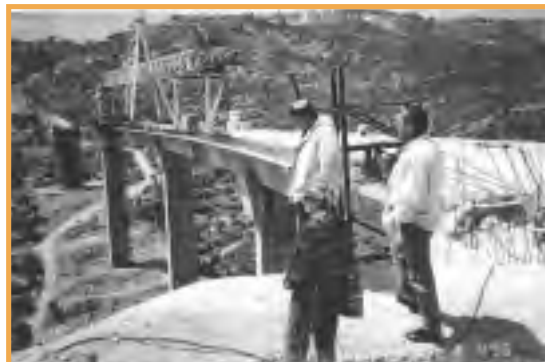
מראה לאחר חיבור בין מספר מיפתחים; רואים עקומה אנכית ואופקית, 6 עמודים בנחל
